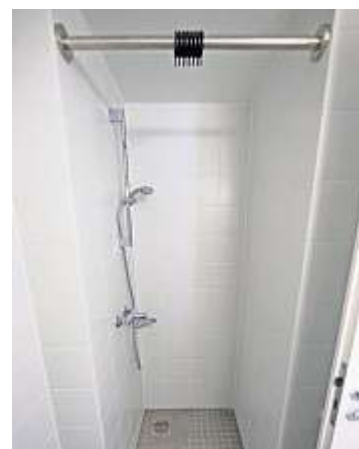
Die Badezimmer wurden als Fertigbauteile eingebaut.
